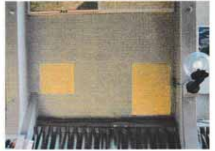
耐震診断の跡
