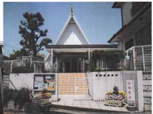
改修前の全景
