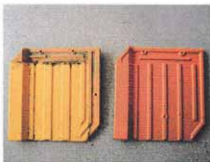
(左) "XPO"70の瓦 (右) 改修で使用した瓦
