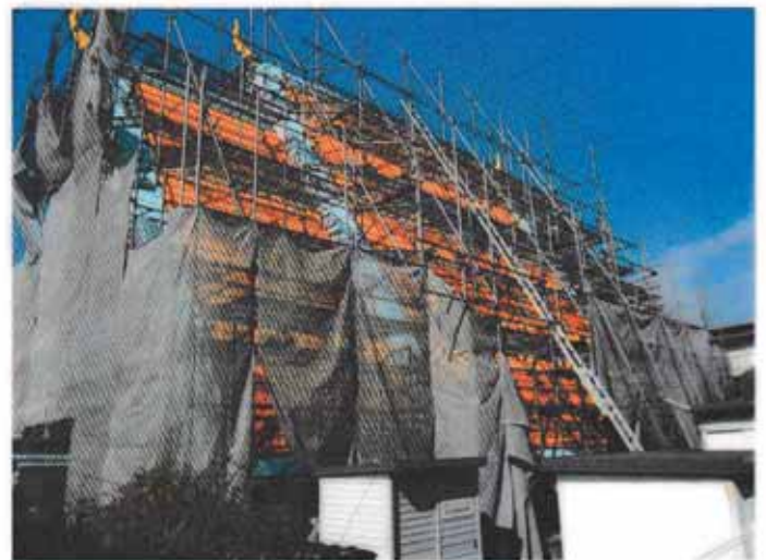
工事中のパビリオン
